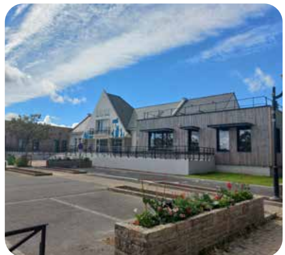
Réhabilitation et extension de la mairie et de l'Espace France Service à Allaire
