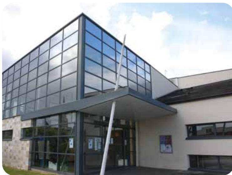
Piscine de Redon
