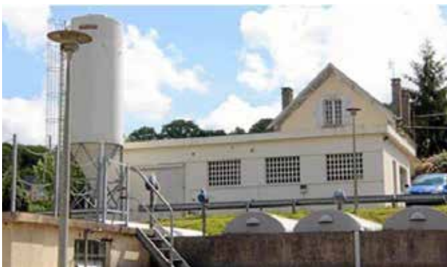
L'usine de production d'eau potable à Redon
