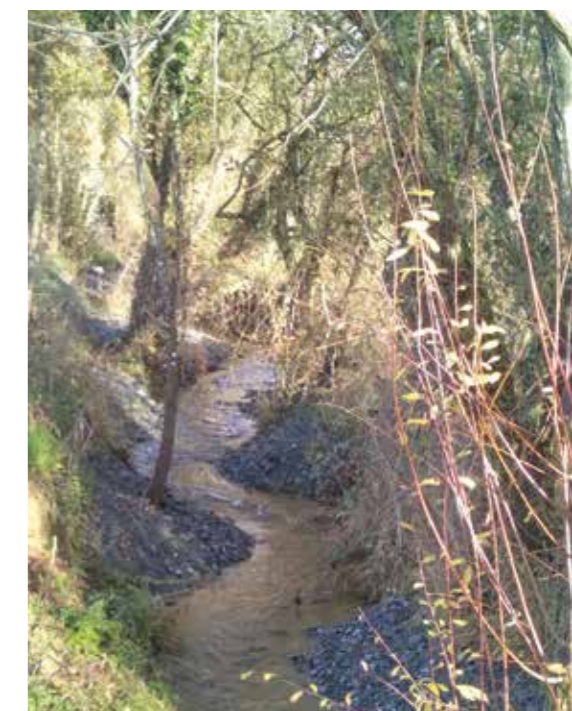
Restauration du ruisseau de la Cave et Bricaudière à Plessé
